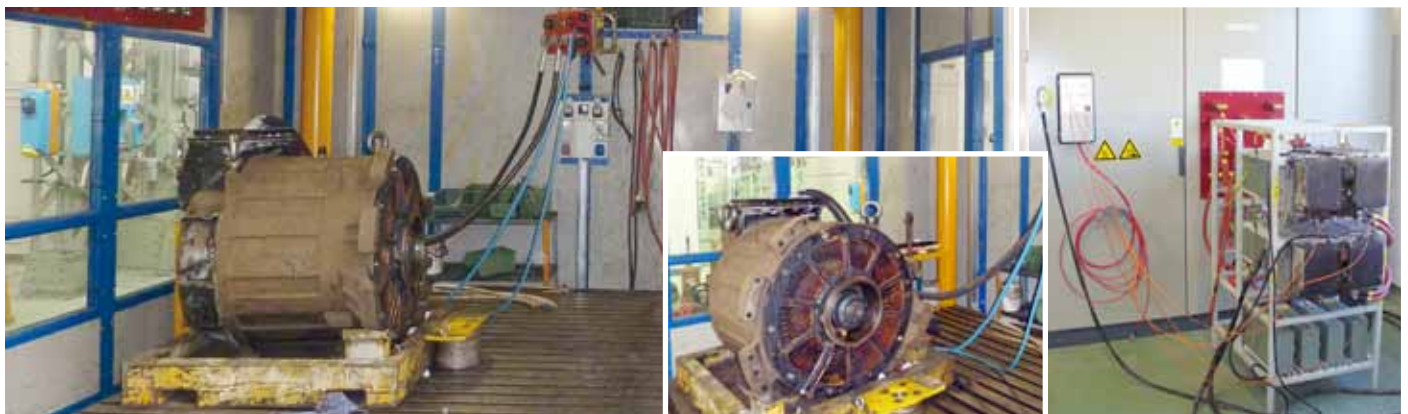
Banc d'essai moteurs de traction asynchrone
